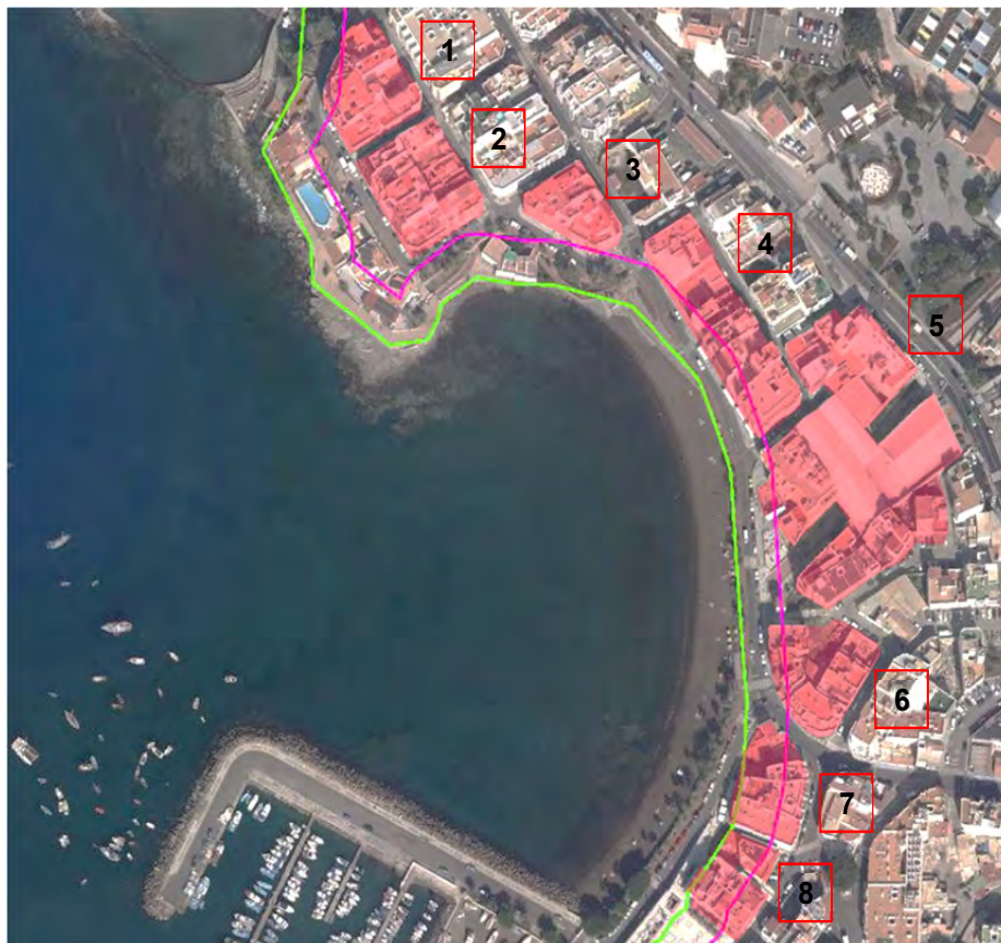
Se señalan las edificaciones de las ocho manzanas objeto de estudio, demostrando que conforman manzanas cerradas
