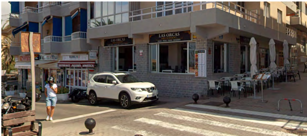
Locales comerciales existentes en la planta baja de la manzana 1 (ordenanza zona V)
