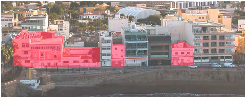
Manzana nº 4. Se señalan las edificaciones que no han alcanzado el número de plantas máximas permitidas por las NNSS de Mogán
