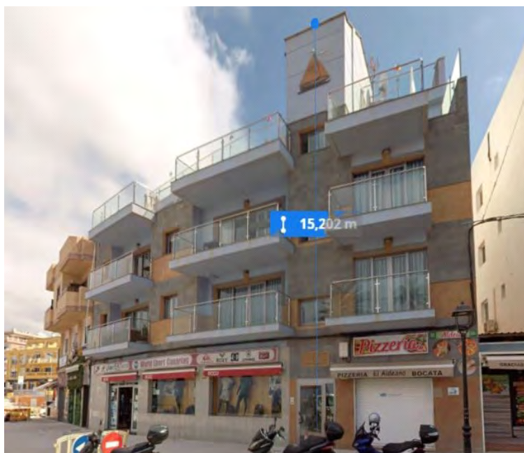
La edificación nº 59 de la calle Miguel Marrero Rodríguez mide 15,20 m de altura
