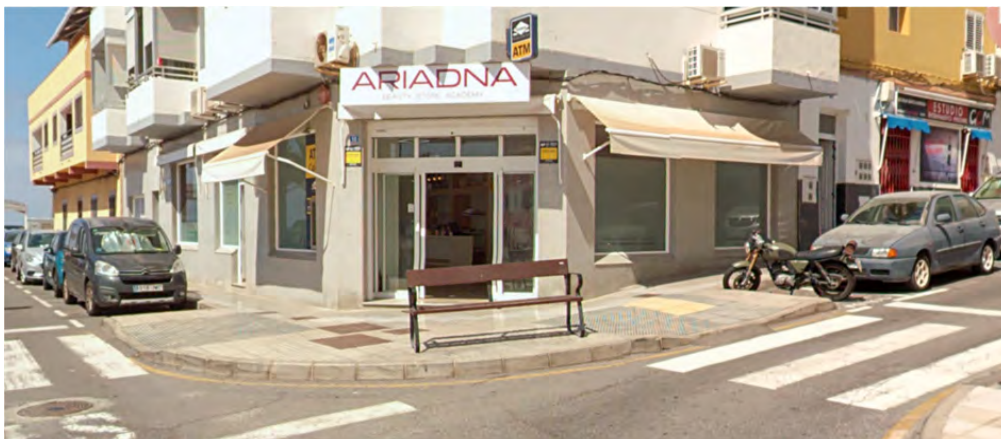
Locales comerciales existentes en la planta baja de la manzana 2 (ordenanza zona V)
